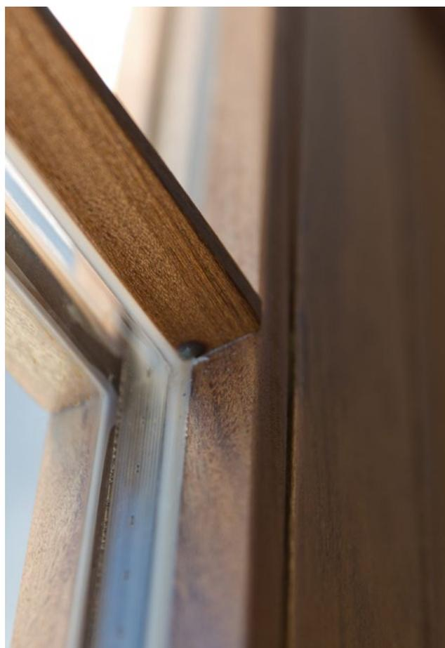
Finition discrète à l'aide d'un joint ► silicone
